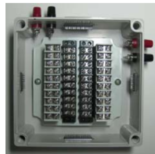
[그림15] 회로박스 부품 설치 사진
